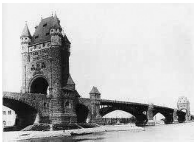
写真-4.12 エルンスト・ルードヴィッヒ橋 注14) (1900年)
