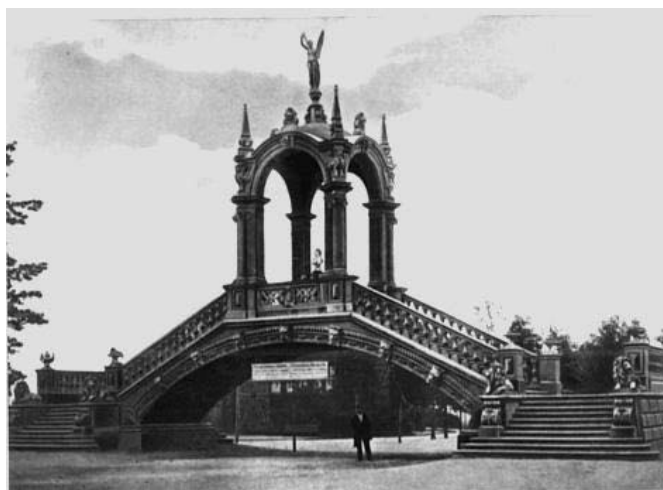
写真-2.5 ドイツ初の突固めコンクリート製歩道橋 (1880) 注14)
