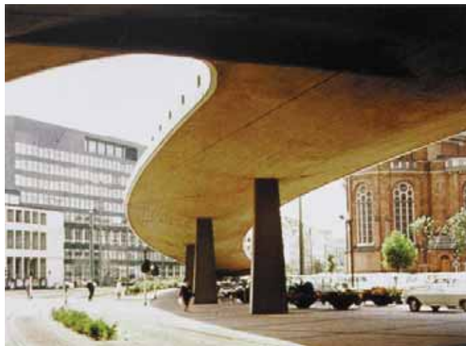
写真-4.9 ヤンベーレムプラッツ高架橋 注10)
