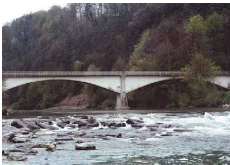
写真 - 3.3 ビルビイル橋(1904 年) (筆者撮影)
