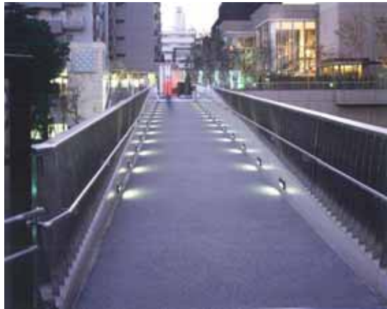
写真-7.10 第2人道橋 夕方の橋上空間 ライトアップ
