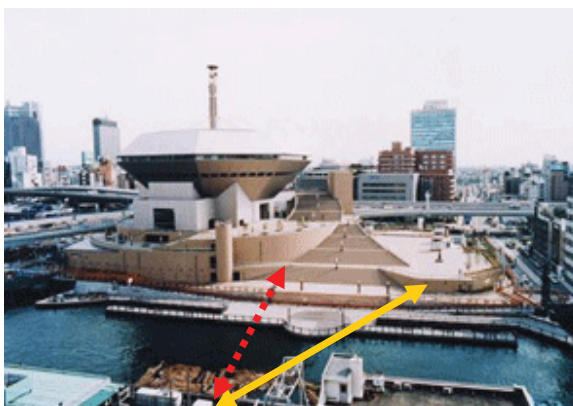
「なんば Hatch」全景と架設位置
