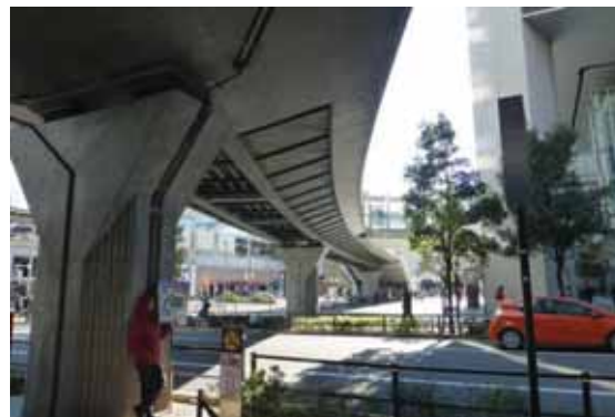
（写真-9.5）桁のスレンダーネス (27.6:1) (筆者撮影) (写真-9.6) 曲率 170m の見え方 (筆者撮影)
