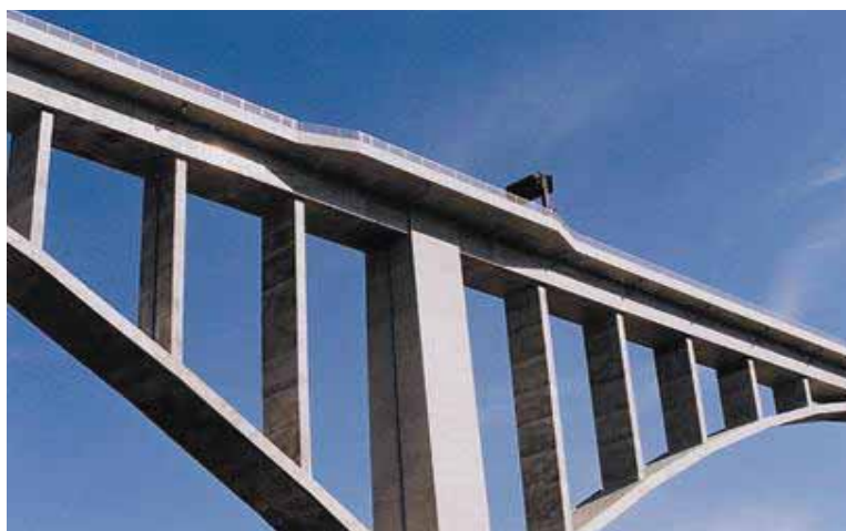
写真-8.3 非常駐車帯拡幅部 付属物のデザイン 1)
