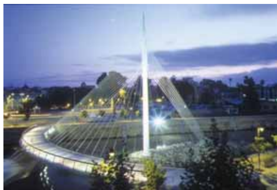
写真 - 6.1 マレコン橋 (Pasarela del Malecon) (提供 : Mike Schlaich)
