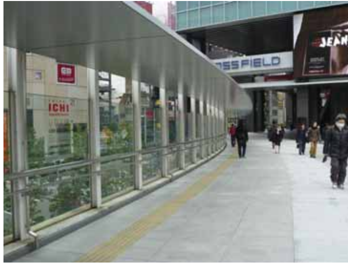
写真 - 9.14 AKIBA BRIDGE 上の防風パネルと屋根（筆者撮影）
