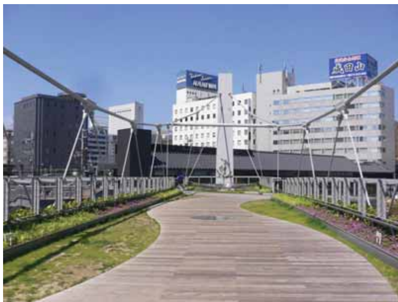
写真-10.6 「浮庭橋の橋面植栽とボードウォーク（著者撮影）
