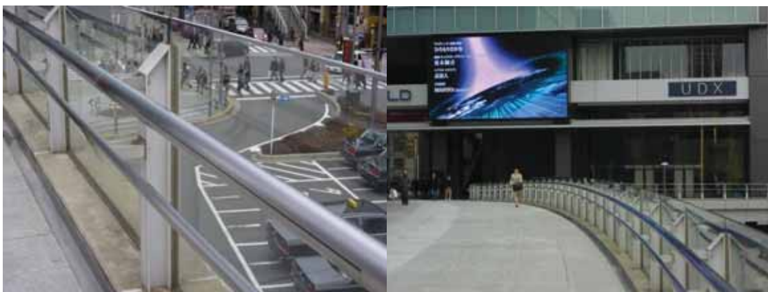
写 - 9.12 AKIBA BRIDGE の高欄，上段手摺φ76.2mmの中に照明を内蔵(筆者撮影)
