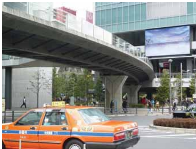
写真 - 9.13 強化ガラスの高欄が脇役，主桁のエッジが主役のデザイン（筆者撮影）
