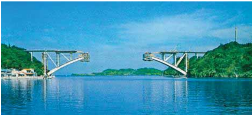
写真－8.1 世界初のアーチの張出架設工法が採用 保川津橋 1979 年 2)
