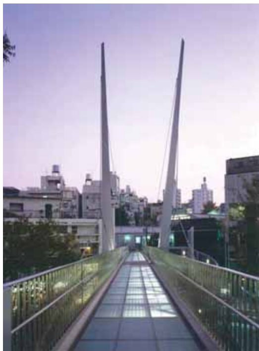
写真 - 7.8 第1人道橋 夕方の橋上空間 ライトアップ
