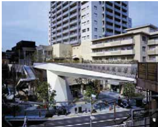
写真-7.9 第2人道橋 跨線橋側からアドレス側を見る
