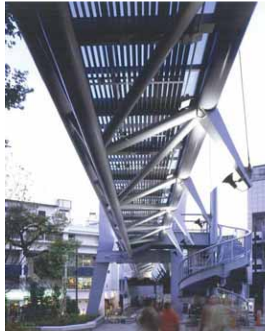
写真 - 7.7 第1人道橋 桁下から見上げた状況
