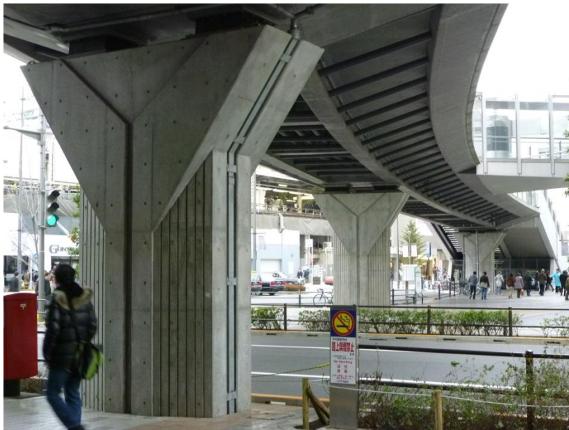
図-9.10 AKIBA BRIDGE の橋脚と主桁断面の関係 3)
