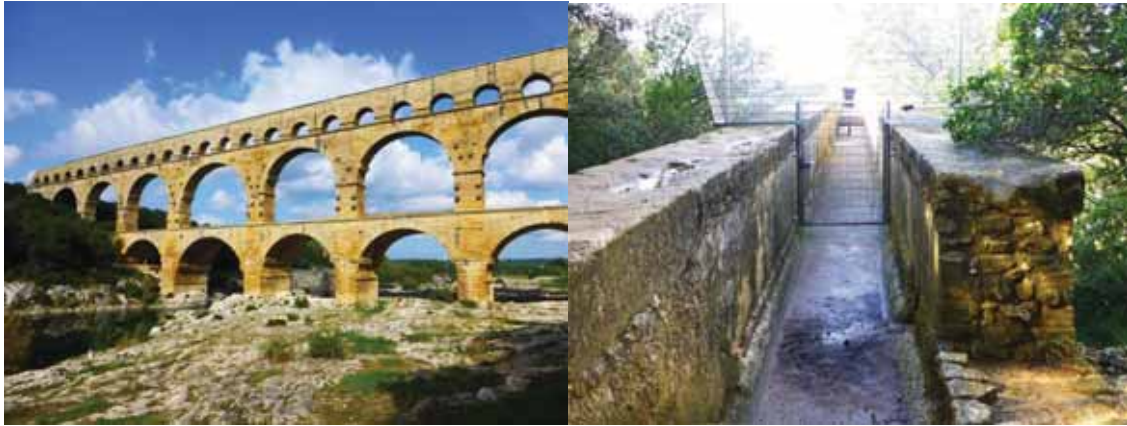
写真-5.2 ガールの水道橋全景 (BC19) (筆者撮影) 写真-5.3 セメント使用の水路 (筆者撮影)
