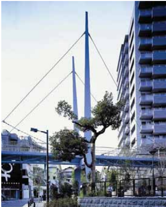
写真 - 7.6 第1人道橋 代官山公園側から見る
