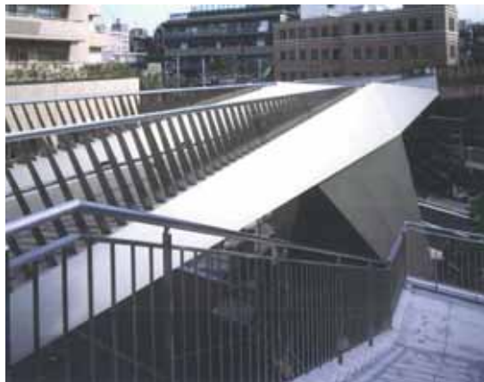
写真-7.11 第2人道橋 アドレス側から跨線橋側を見る
