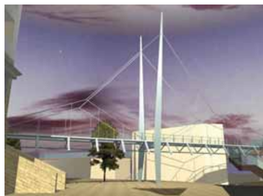
図 - 7.12 第1人道橋 斜張橋案のCG (斜材形状: ファン型) 図 - 7.13 第1人道橋 吊り形式案のCG
