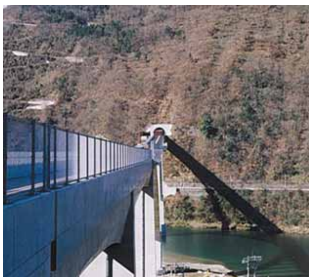
写真-8.4 落下物防護柵のデザイン 1)
