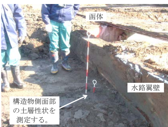
写真-4.4.3 構造物側面部の変状の計測
