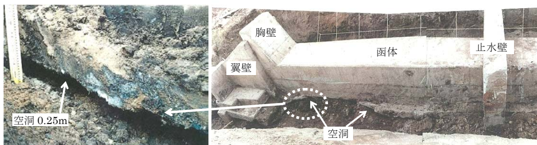
写真-4.6.3 R樋門の函体および底板下の状況
