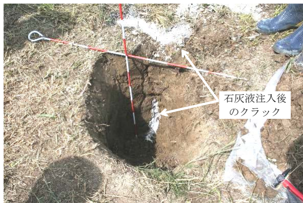
写真-4.3.4 法面クラックの計測
