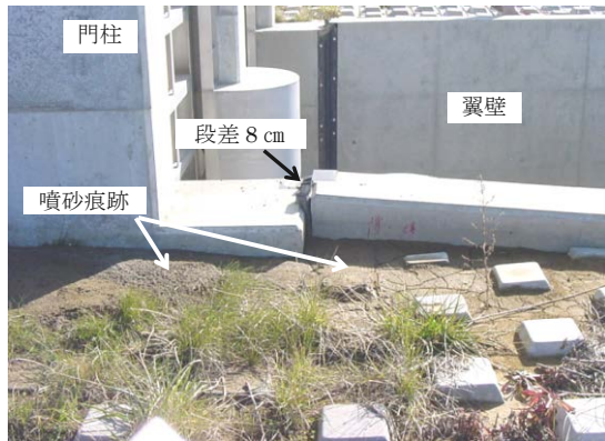
写真-4.3.8 地震後の門柱周辺の変状の計測 門柱、翼壁、護岸、地盤との接続部の変状、損壊、液状化などを観察・計測する。
