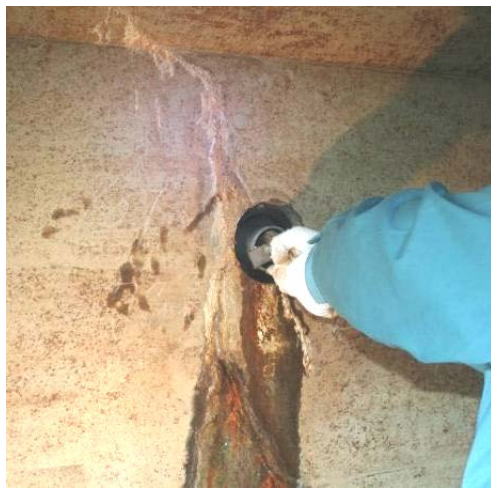
写真-4.3.10 調査孔からの計測 調査孔の浸出水・周辺の色調やクラック、孔外の土質性状などを観察・計測する。
