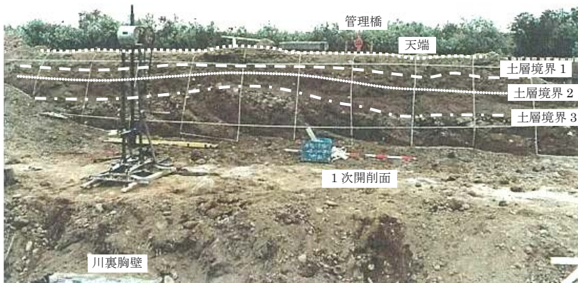
写真-4.6.1 R樋門のA断面土層状況
