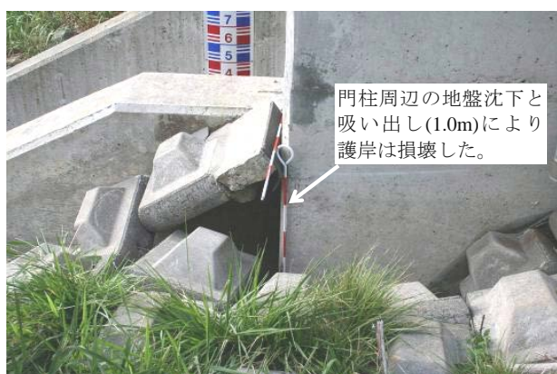
写真-4.3.7 門柱周辺の変状の計測
