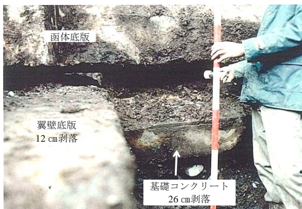
写真-4.4.4 函体底版部の変状の計測
