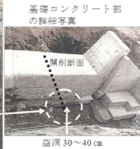
写真-5.2.9 函体周辺土層の変状形態
