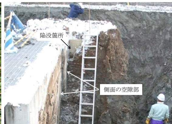
写真-5.2.18 陥没箇所周辺の開削状況
