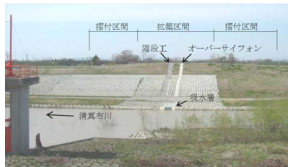
写真-7.2.2 地上配管式オーバーサイフォン
