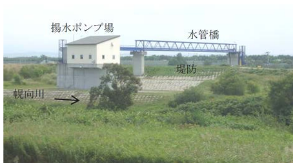
写真-7.2.1 水管橋式オーバーサイフォン
