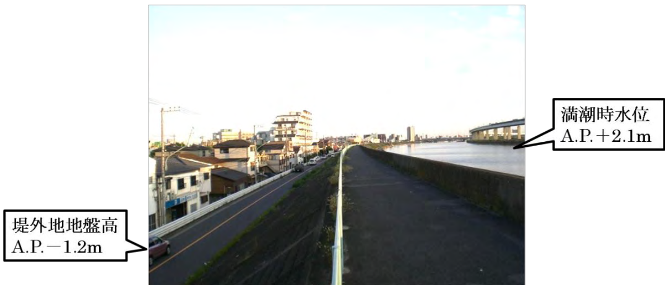
写真3-1 満潮時の中川左岸(荒川左岸)
