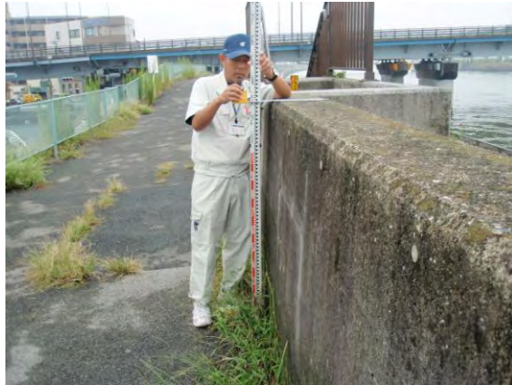
写真 3-4 荒川左岸嵩上げパラペット
