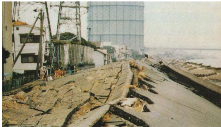
写真 3-3 阪神淡路大震災時の淀川左岸堤(全日本建設技術協会, 1995)
