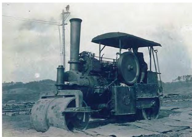
写真-3.1 山口貯水池 10t 蒸気ローラによる転圧状況
