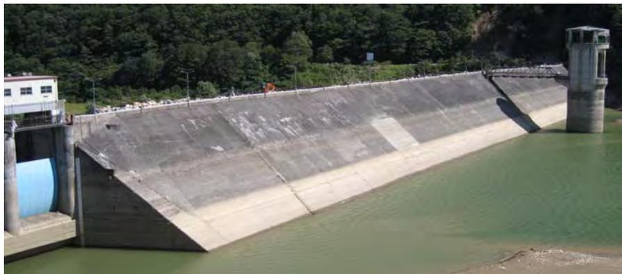
写真-4.6 地震発生3ヶ月後の石淵ダム上流コンクリート遮水壁(2008年著者撮影)
