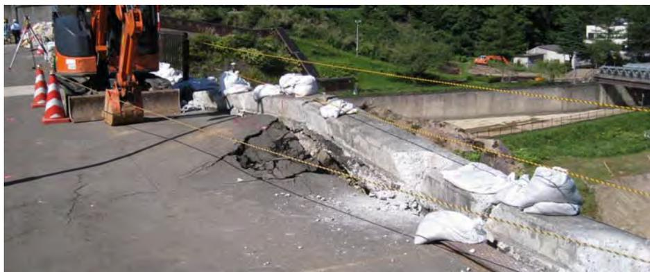
写真-4.7 地震発生3ヶ月後の石淵ダム天端被災調査状況(2008年著者撮影)
