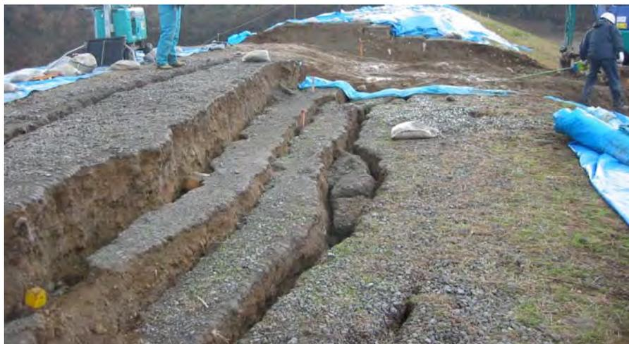
写真-4.3 地震後の浅河原調整池ダム堤体天端のクラック(2004年著者撮影)
