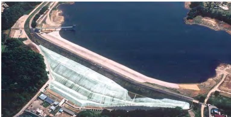
写真-2.3 山倉ダム第一堰堤全景(堤体強化工事後, 2004年5月撮影)
