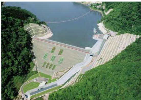
写真-2.1 山王海ダム全景(堤体嵩上げ工事完了後, 2002年11月撮影)
