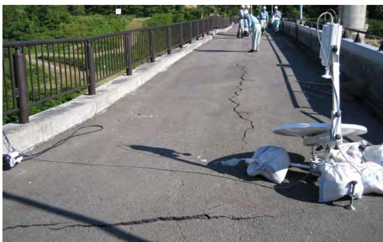
写真-4.5 地震直後の石淵ダムの堤体天端のクラック(2008年著者撮影)
