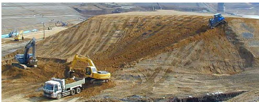
写真-5.6 材料仮置土(ストックパイル)スライスカット状況(1999年3月)
