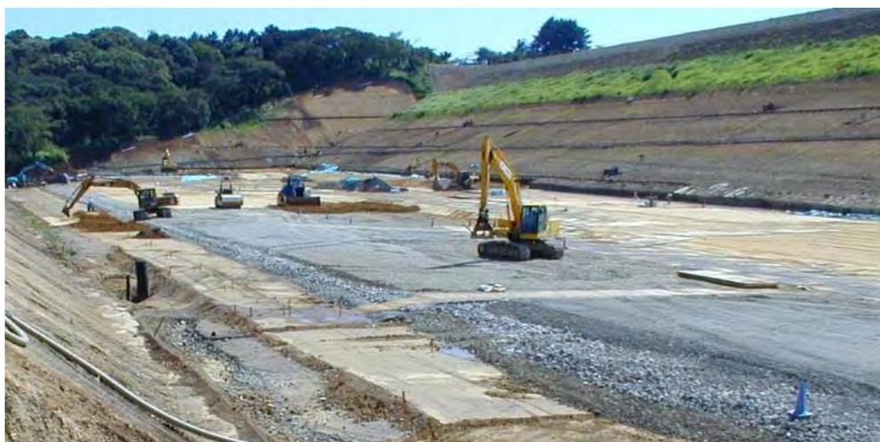
写真-5.12 下流水平ドレーン施工状況(2000年7月, 著者撮影)
