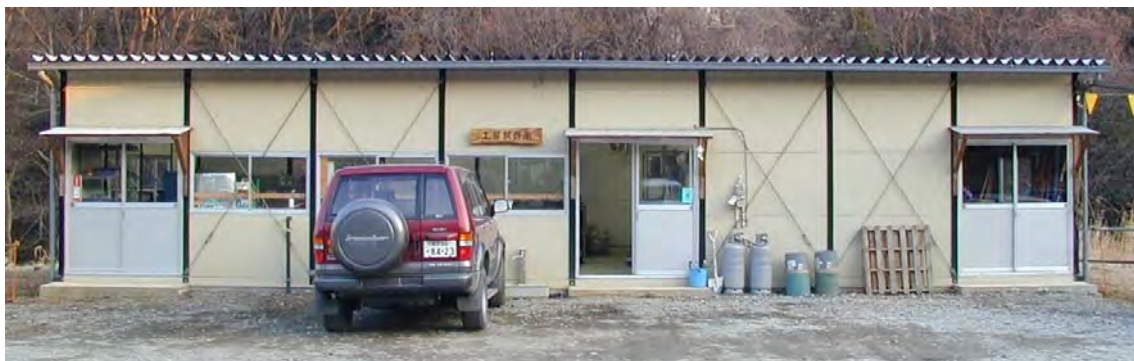
写真-6.6 現場に設けた試験室の例(山口貯水池堤体強化工事, 2001年著者撮影)
