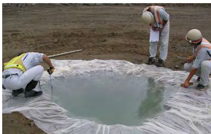
写真-6.5 ロック材料(最大粒径1m)の水置換法による現場密度試験状況(胆沢ダム建設工事)
