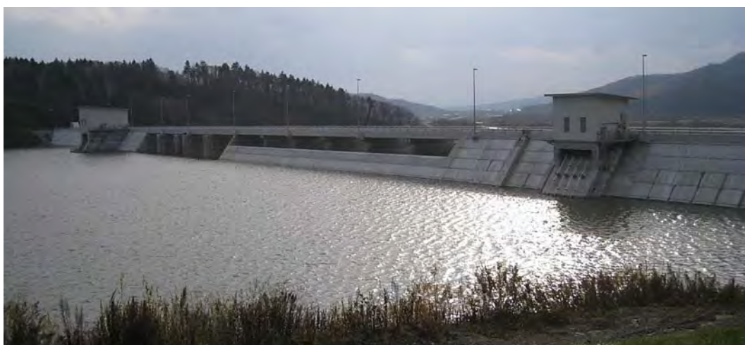
写真-7.15 完成した当別ダム(上流側全景, 2012年著者撮影)
