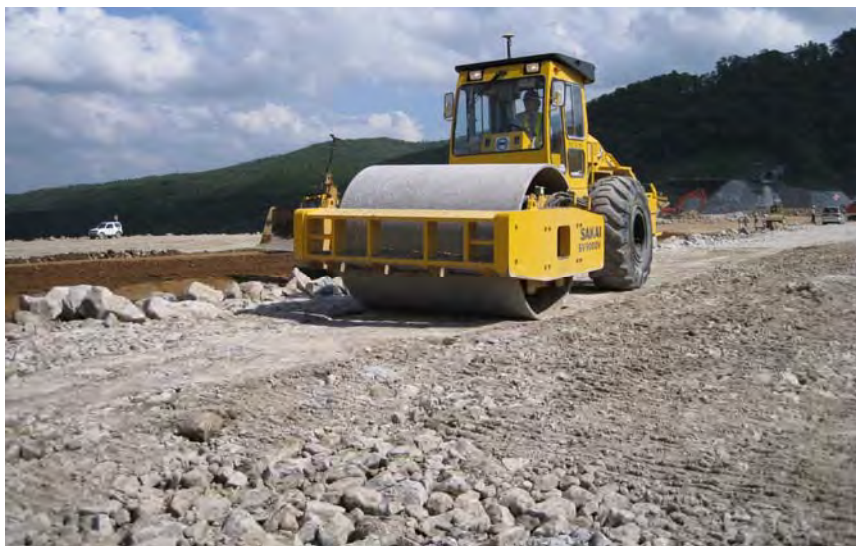
写真-6.4 振動ローラによるロック材料の転圧状況(胆沢ダム建設工事, 著者撮影)
