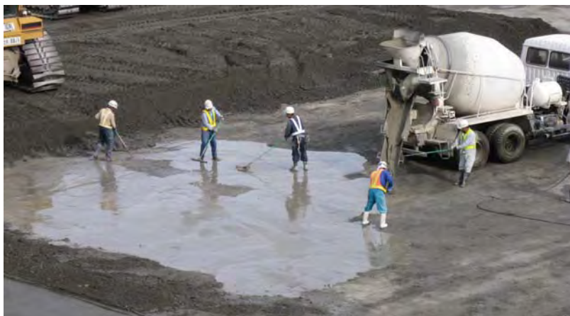
写真-7.5 CSG 打設面へのセメントペースト敷設(当別ダム, 2009年, 著者撮影)
