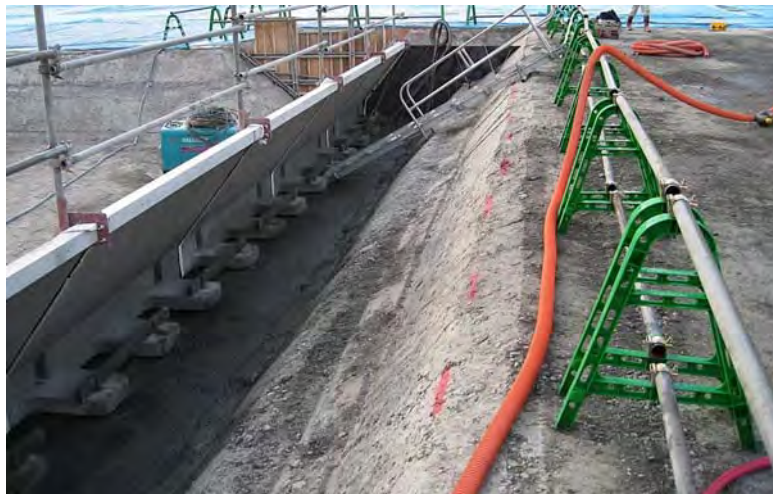
写真-7.10 プレキャスト型枠設置状況(当別ダム, 2009年, 著者撮影)
