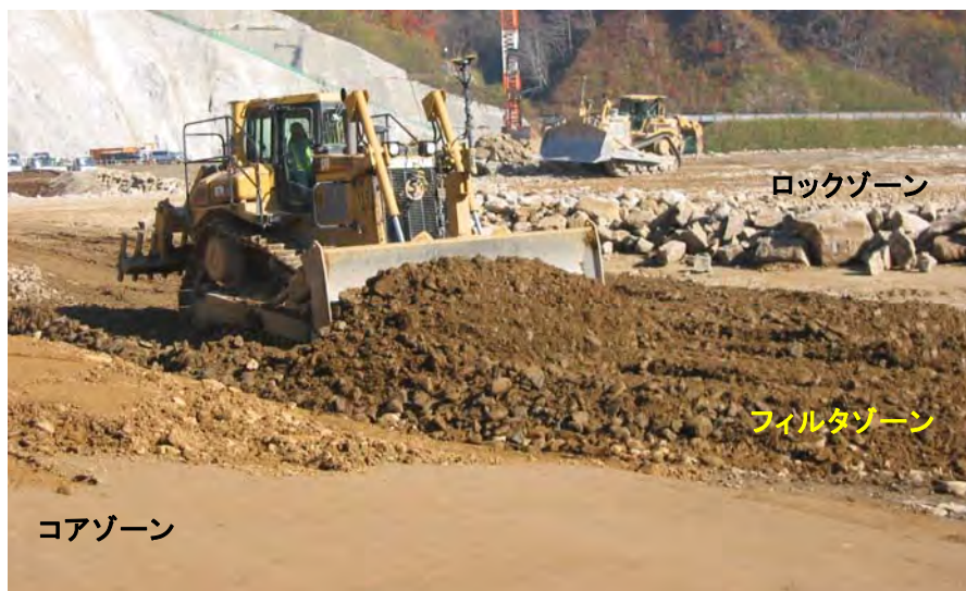
写真-6.2 フィルタ材料の敷均し状況(胆沢ダム建設工事, 著者撮影)
