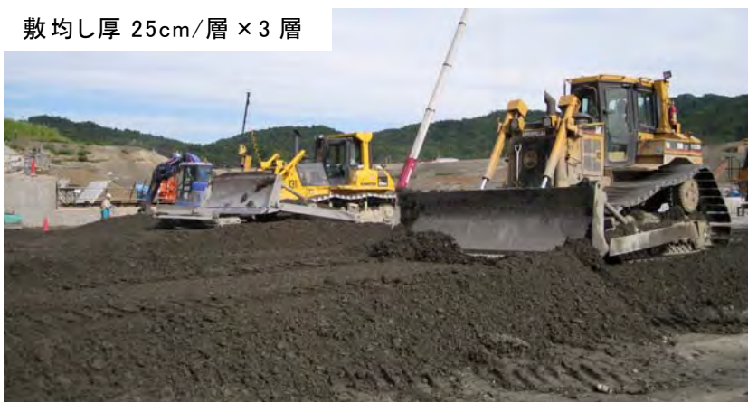
写真-7.7 CSG 敷き均し状況(当別ダム, 2009年, 著者撮影)
