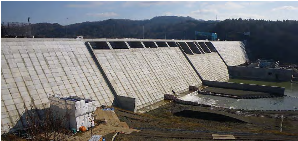
写真-7.13 完成した当別ダム(2011年, 著者撮影)
