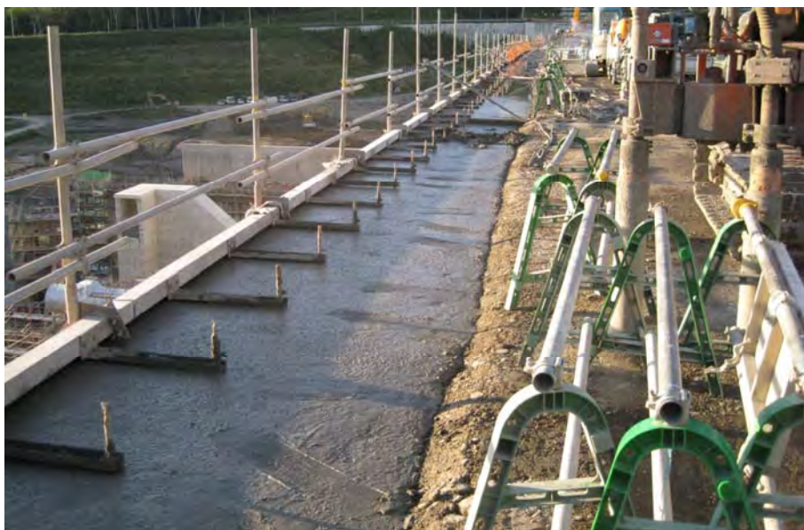
写真-7.11 保護コンクリートの打設(当別ダム, 2009年, 著者撮影)
