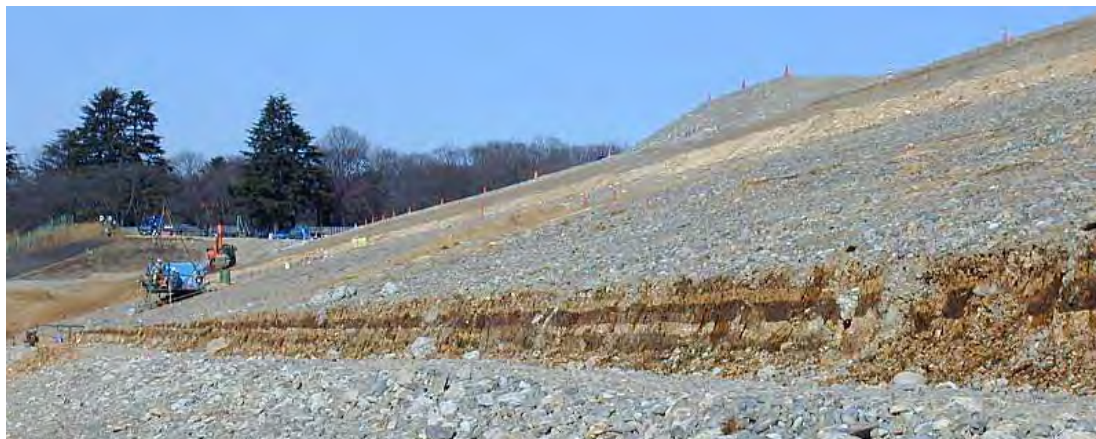
写真-6.9 山口貯水池既設堤体上流サヤ土の盛立跡全景(1999年, 著者撮影)
