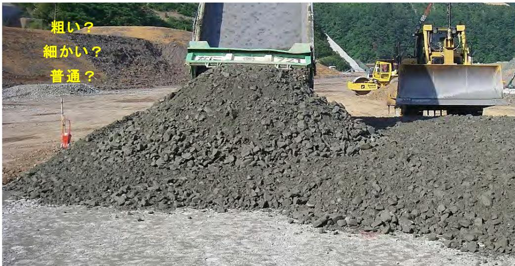
写真-8.1 フィルダム施工現場における盛立材料まき出し状況（フィルタ材）
