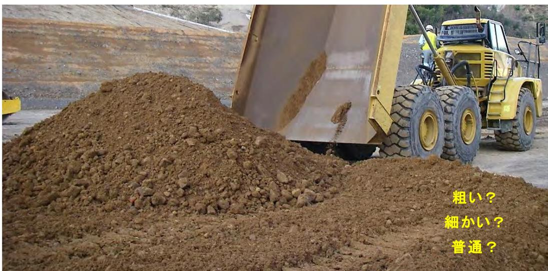
写真-8.2 フィルダム施工現場における盛立材料まき出し状況（コア材）
