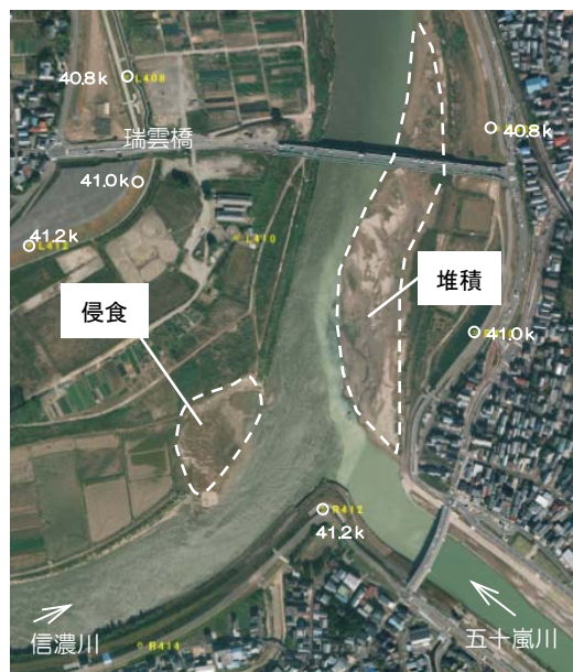
写真 2-3 平成 23 年 7 月洪水における侵食・堆積の状況
