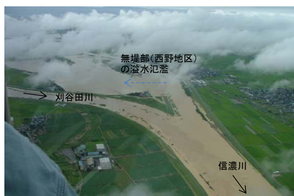
写真 2-2 平成 23 年 7 月洪水における無堤部の氾濫状況
