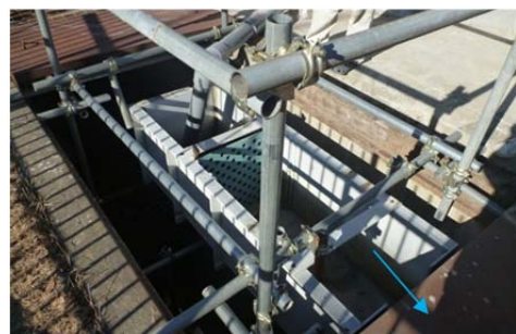
下流端 量水槽
