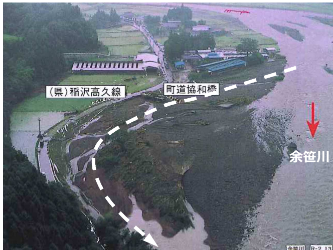
写真 3-1-1 1998年8月余笹川流域で発生した洪水による側方侵食 2)
