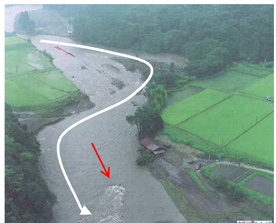
写真 3-1-5 1998 年（平成 10）洪水の侵食状況 2)
