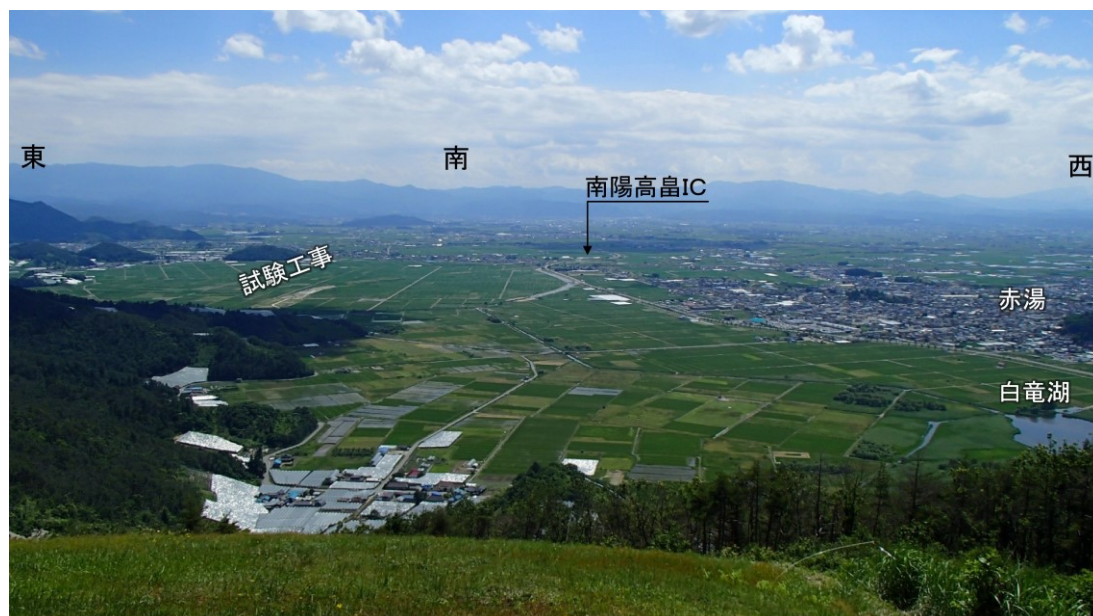
図 2-3 白竜湖軟弱地盤の周辺状況の写真
