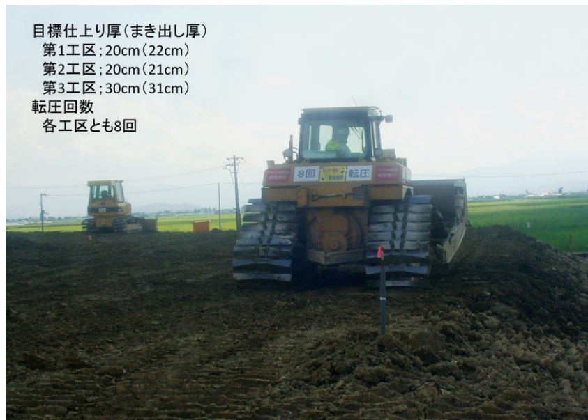
図 4-9 ブルドーザ転圧の状況
