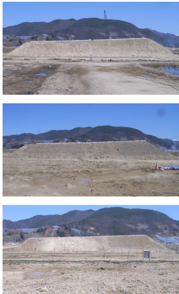
図 4-10 盛土完了後の状況(上から Area1, Area2, Area3)
