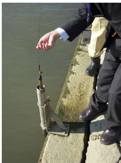
図 3-15 1.6km に設置された圧力式水位計
