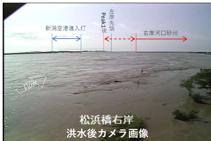
(b) 洪水後の CCTV カメラ画像
