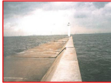
第7防波堤の法線出入状況
