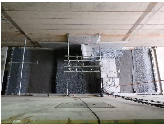
(a) 転倒状況
