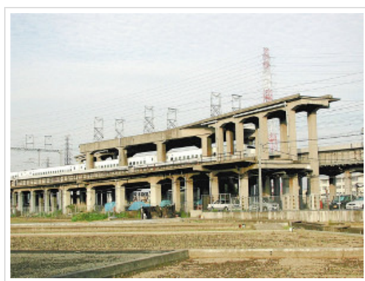
写真1 撤去工事が始まる前の貨物新幹線の高架橋（2003年5月）＝大阪府摂津市
