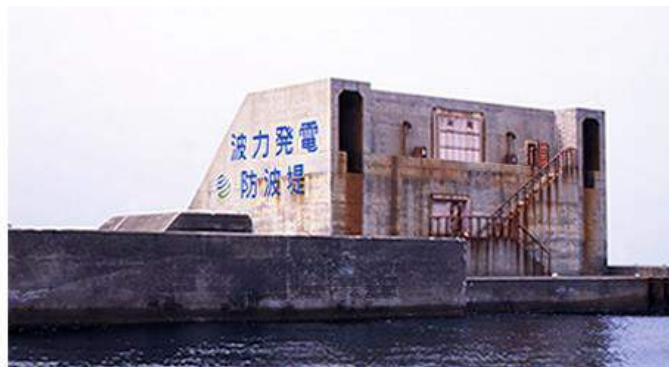
図 1.5 酒田港防波堤設置型 OWC (定格 60 kW)
