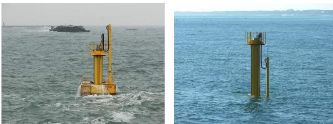
図4.12 沈降システム確認運転：浮上（左） 沈降(右)
