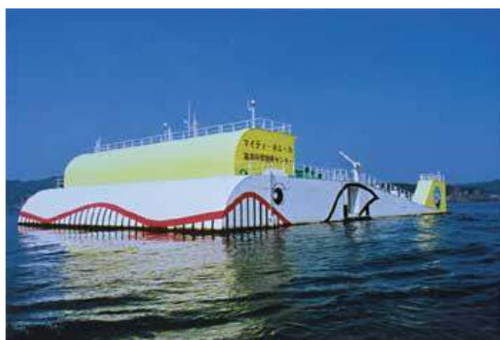
図 1.6 沖合浮体式 OWC 「マイティホエール」 (定格 110 kW)
