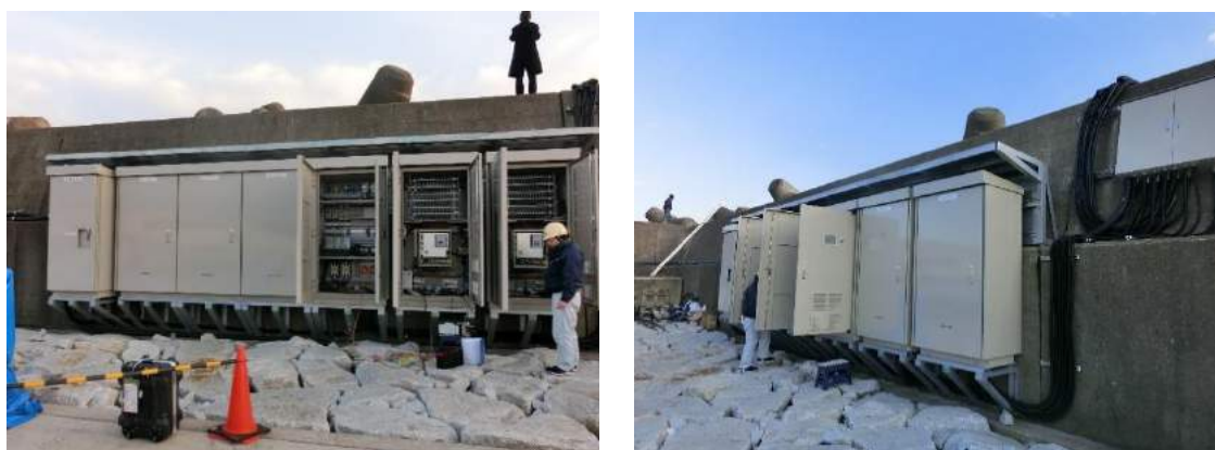
図4.13 制御盤設置作業
