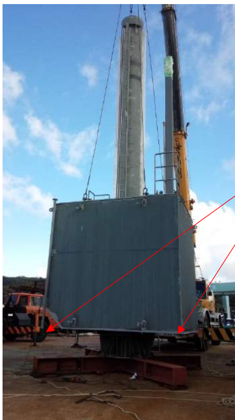
図4.6 波センサーの取付
