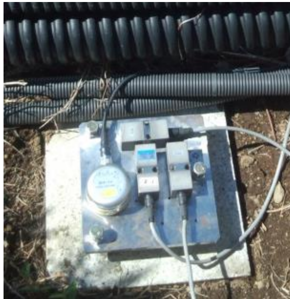
図 2-18 計器の設置状況
