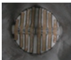
図2 散気管の様子
