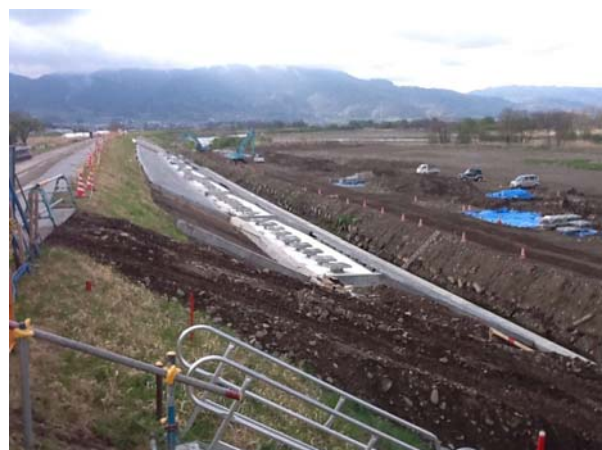
写真7-2 矢板打設後の遮水シート、護岸施工状況 2013年 須坂地区
