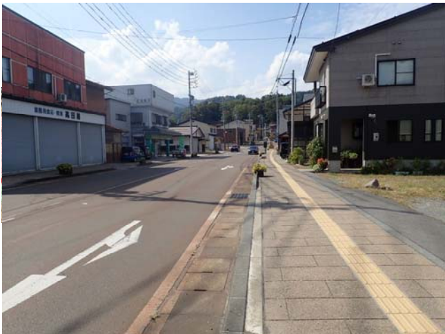
写真 4-3-2 飯山市街地の旧河道(踏切手間部分が低い)
