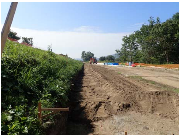
写真7-1 中央橋下流右岸(33kp付近)の遮水対策の施工状況(2019年10月) 矢板打設位置の掘削作業
