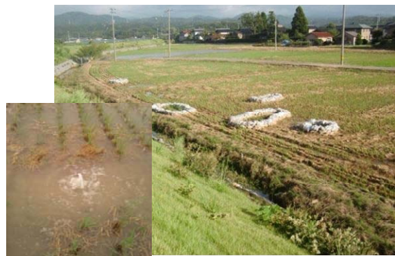
写真 5-1-2 荒木田地区(左岸 9.5kp 付近)の漏水状況(漏水のみ)
