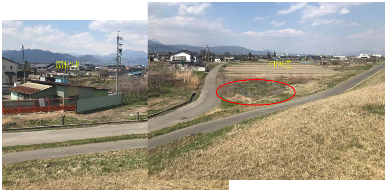
写真 6-4-3 左岸 68.5kp 付近の扇状地と旧河道の状況 堤内地側に扇状地の微高地(集落)が広がる。旧河道との境界付近に湿地あり
