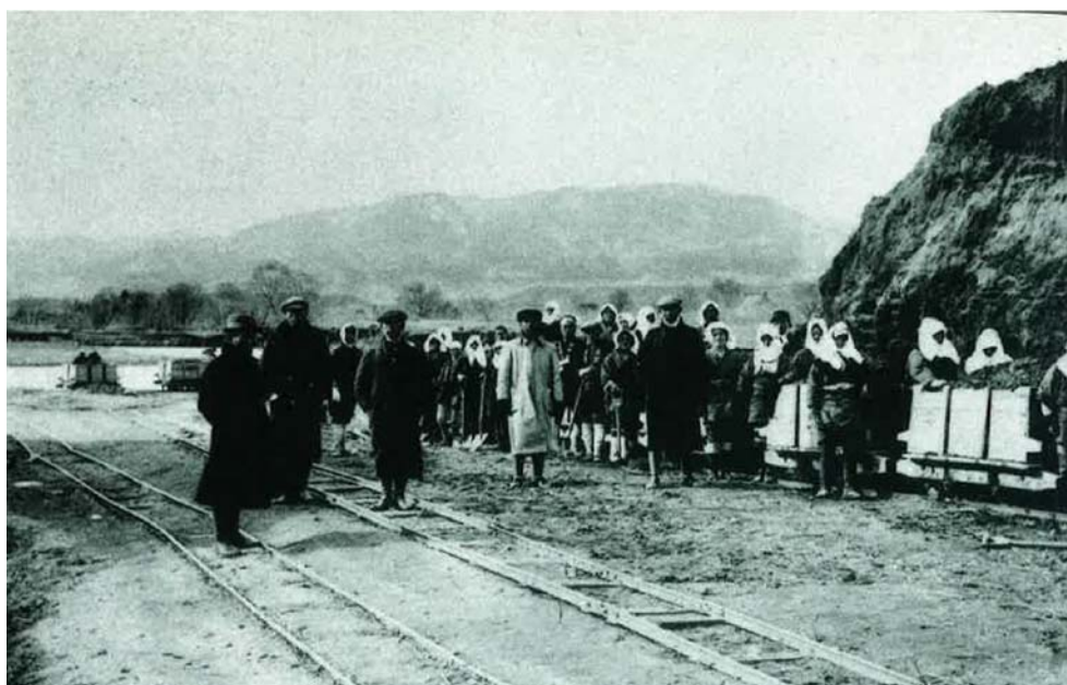
写真 3-2-5 トロッコによる新堤工事(大正 13 年 豊洲村)「信濃の巨流 千曲川」 8)
