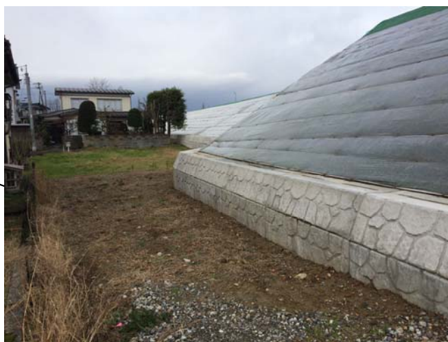
写真 7-3 諏訪地区の堤内基盤排水工施工状況
