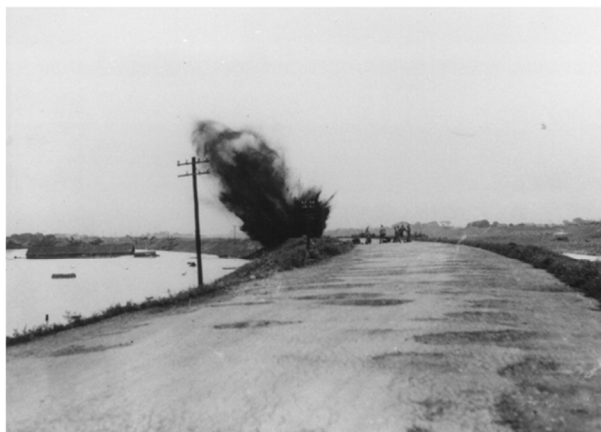
江戸川堤防の爆破状況
