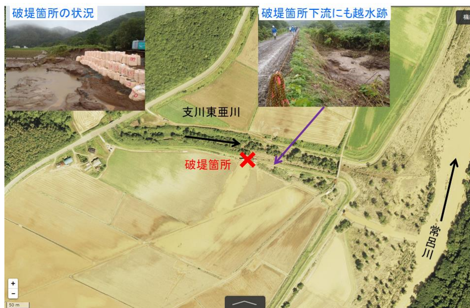
図 2.5.4.5 支川東亜川破堤箇所
