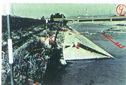
図 2.3.2.3 護岸被災事例 ②上流侵食を伴う破壊③下流侵食を伴う破壊
