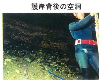
図 2.3.2.2 護岸被災事例 ①基礎からの破壊
