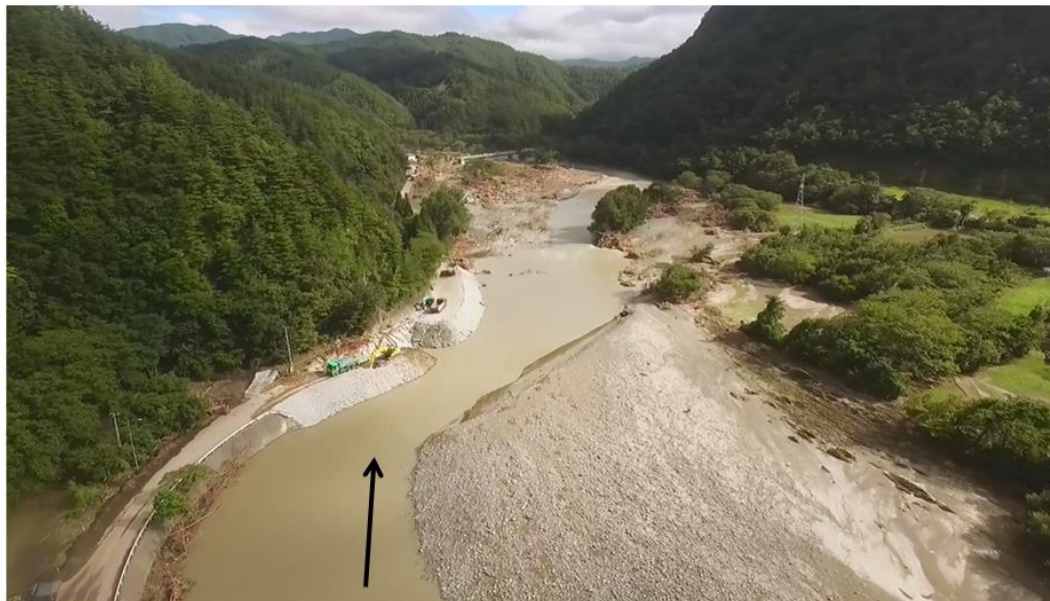
図 2.2.1.8 小本川 ( I_b=1/190 セグメント1) 砂州水衝部における道路復旧難航箇所 (提供：国土交通省東北地方整備局) 8)
