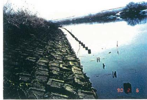
※H元災害ではない
