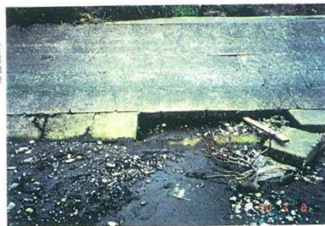
※H元災害ではない
