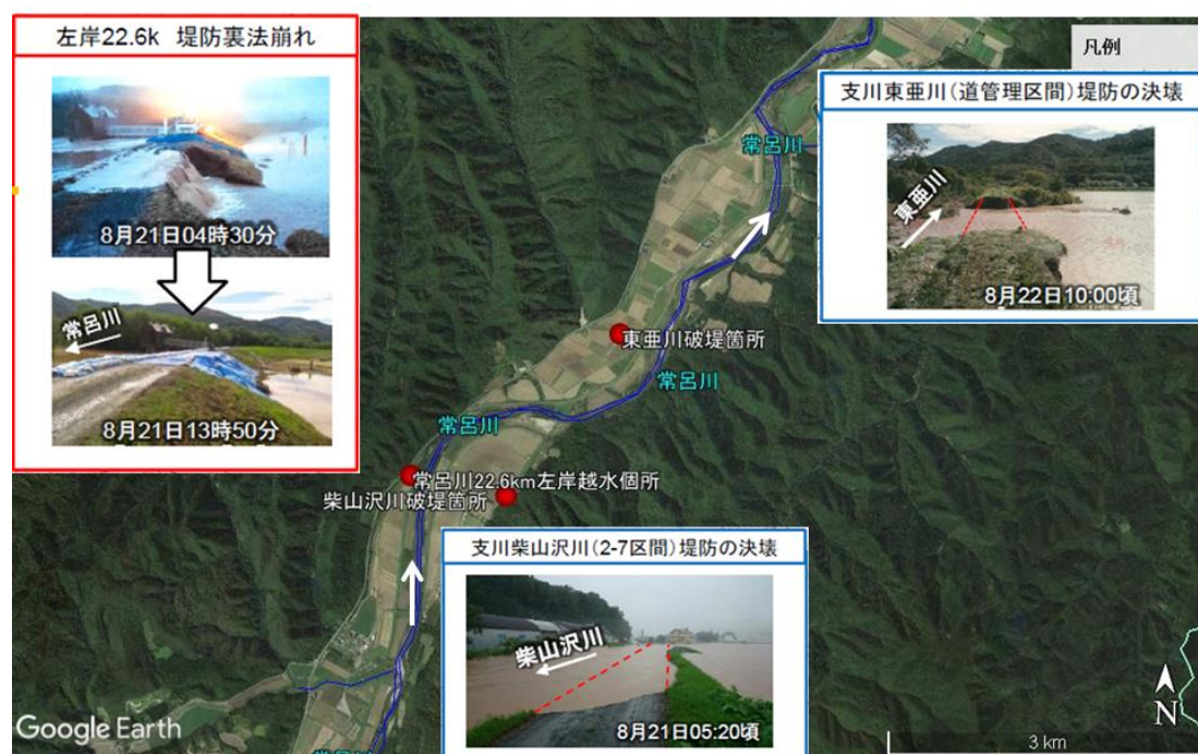
図 2.5.4.1 常呂川 22.6km 左岸、支川柴山沢川左岸、支川東亜川右岸越流 3 箇所
