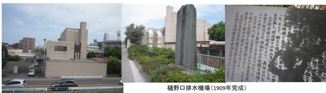
樋野口排水機場(1909年完成) 図 3.1.2.3.2.6 排水不良問題解決を大きく改善した樋野口排水機場
