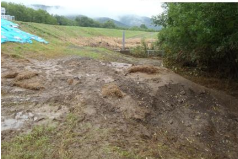
樋門操作員が堤内側水位記録→後日収集
