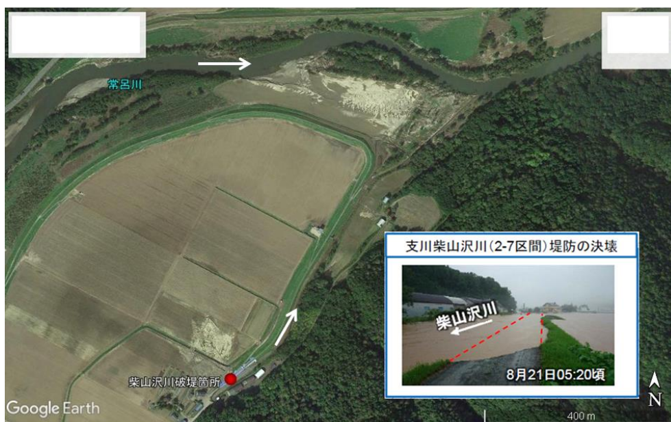
図 2.5.4.4 支川柴山沢川左岸堤破堤箇所
