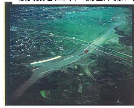
被災顕著区間(上流右岸側から)
