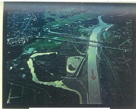
下流改修済み区間
