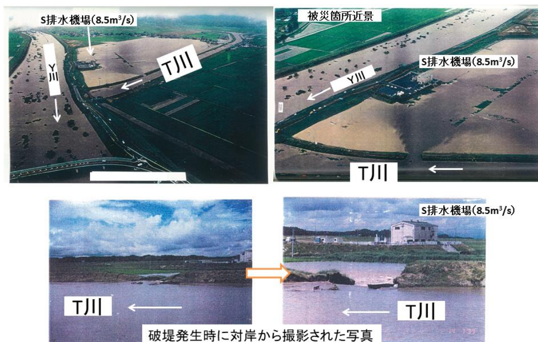
図 2.4.3.8 樋管部分での浸透破堤の発生状況
