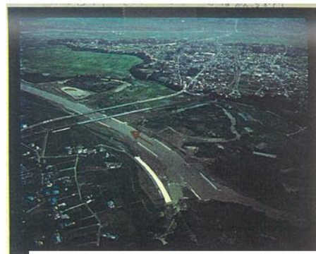
被災顕著区間(上流左岸側から)
