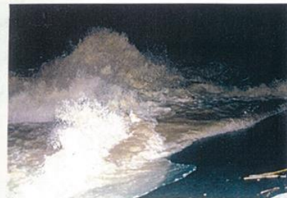
流入堤流入状況 (8/15AM3:00 アスファルトフェーシング被災時)
