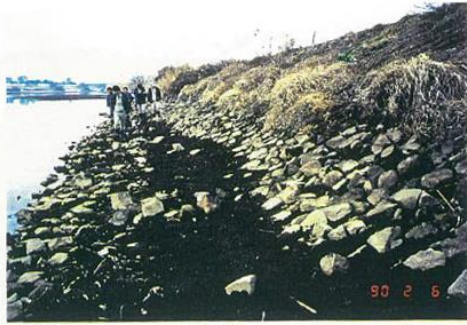
※H元災害ではない
