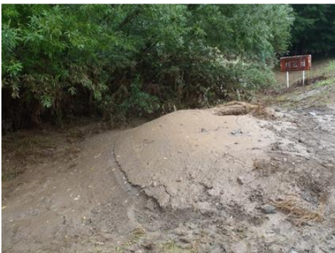
落堀洗掘土砂の堆積状況→湛水を示唆
