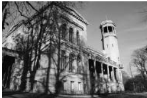
写真-1 ビーズドルフ城（ベルリン）外観
