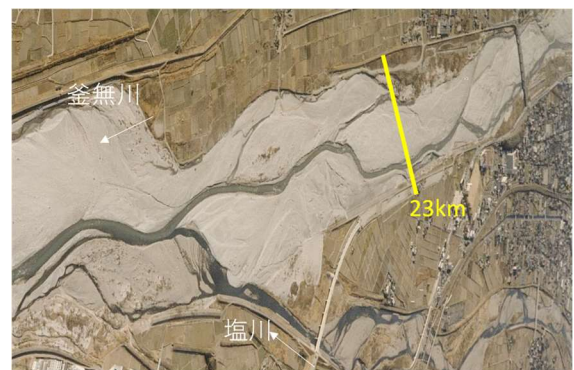
図-15 洪水直後の航空写真(23km付近)
