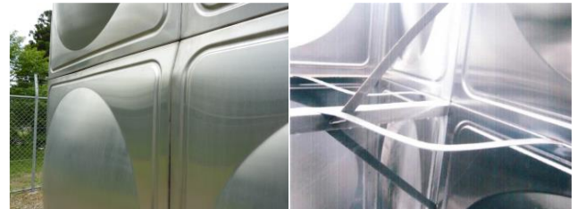
(a) タンク下部での被害
