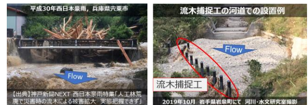
写真-3 (左) 豪雨時の流木による橋梁閉塞の事例 写真-4 (右) 河道への流木捕捉工の設置例
