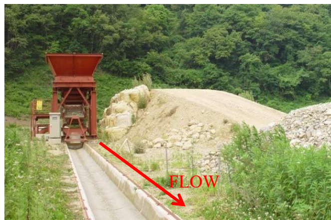
図 5-1 単一石礫流送実験に使用されたコンクリート製大型開水路 16)-18)
