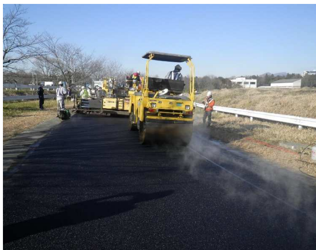
写真-3.2 低燃費舗装 Type1 転圧状況
