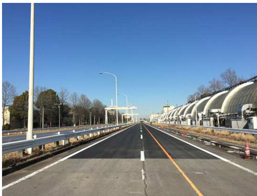
写真-2.2 試験施工の完了
