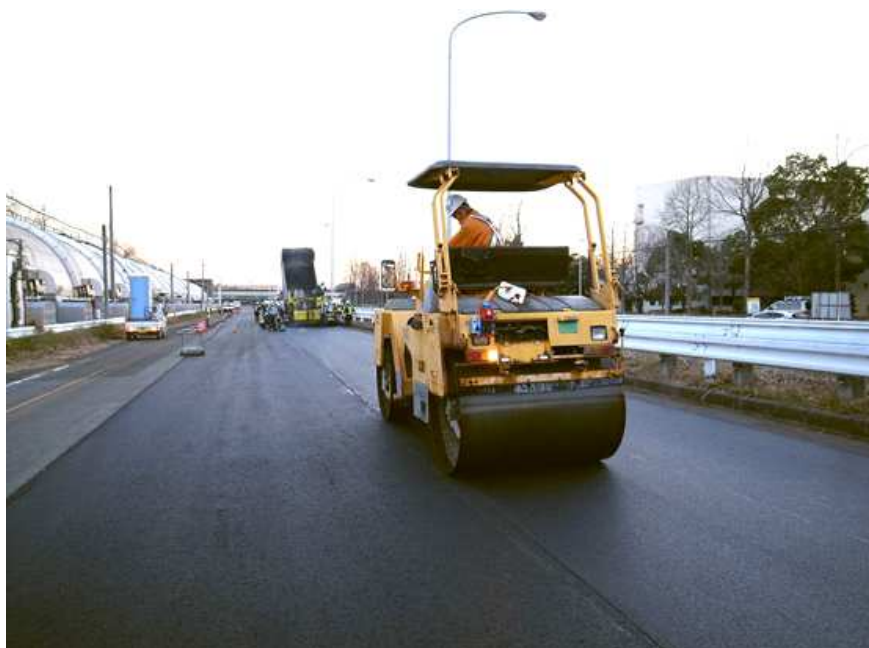
写真-2.1 試験施工の施工状況
