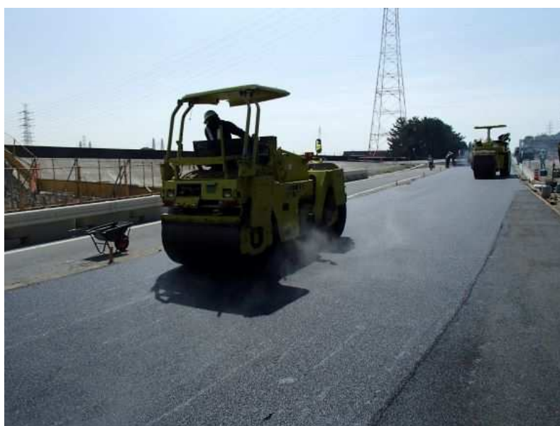
写真-3.4 舗装状況
