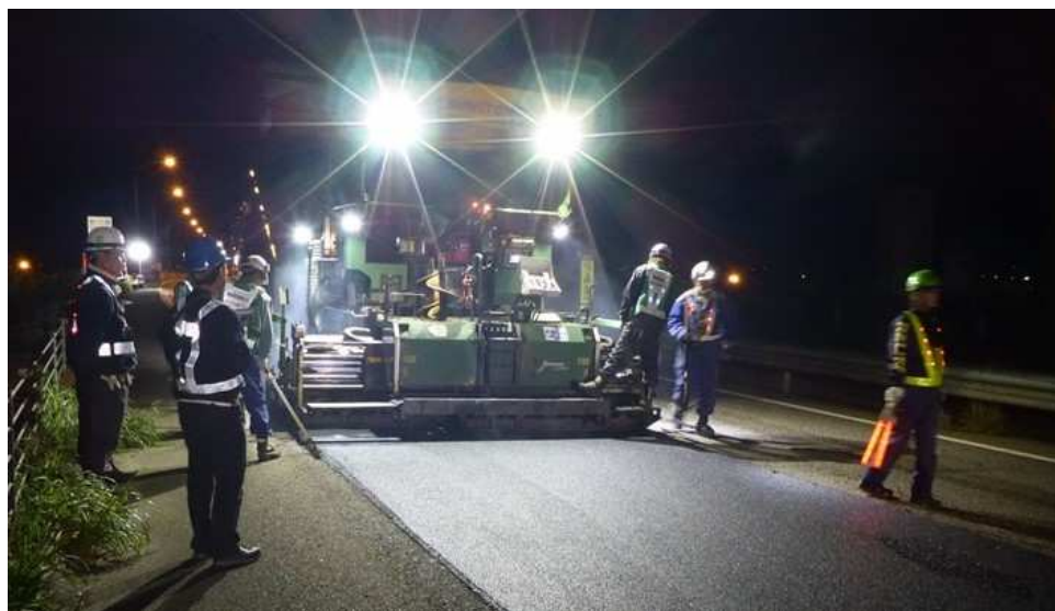
写真-3.7 施工状況
