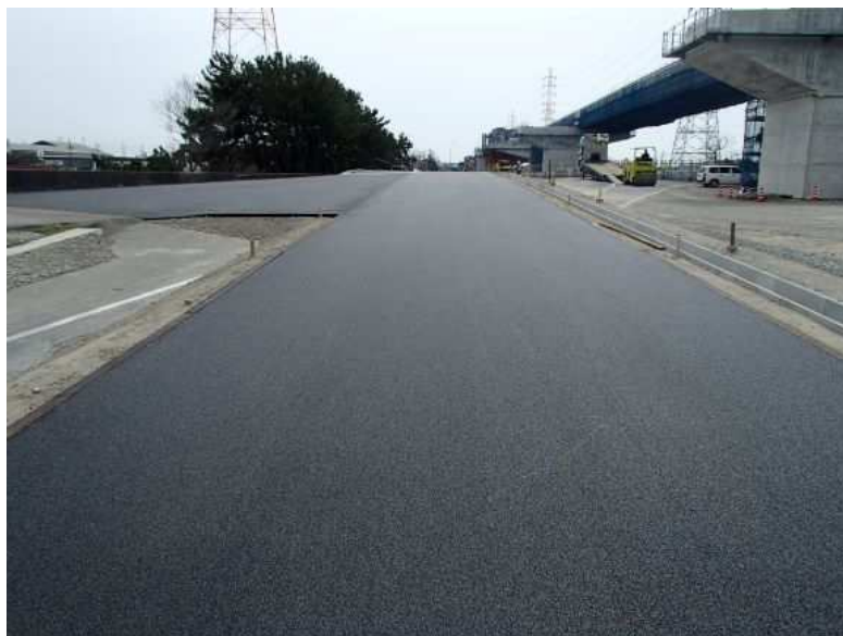
写真-3.5 施工後の状況
