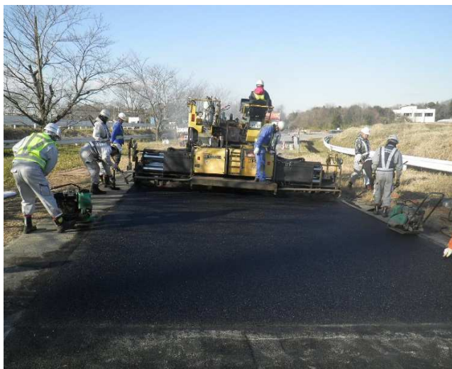
写真-3.1 低燃費舗装 Type1 敷き均し状況
