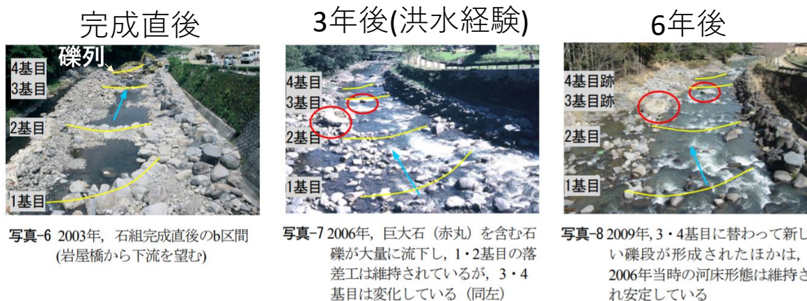
図 4-18 岩岳川における分散型落差工の変化 1)
