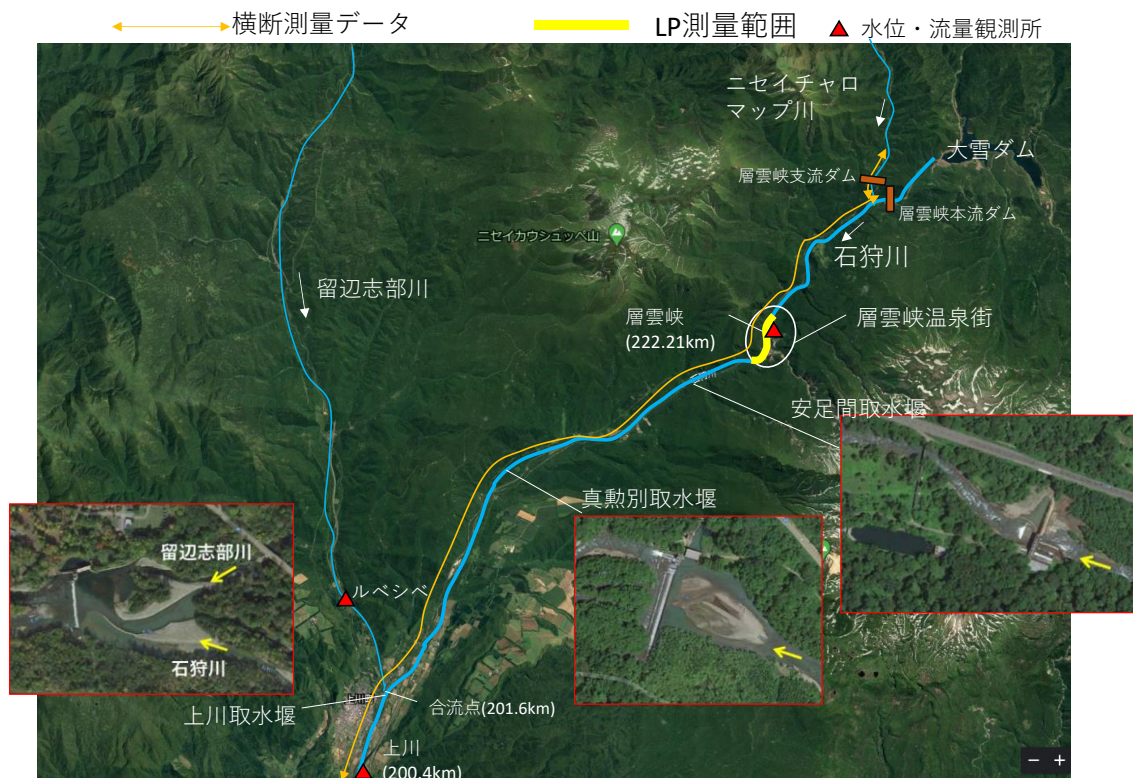
図 3-30 石狩川の大雪山ダム直下～上川観測所までの航空写真
