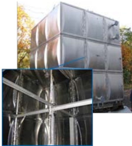
写真-4.1.1 ステンレス製パネルタンク (SUS タンク)
