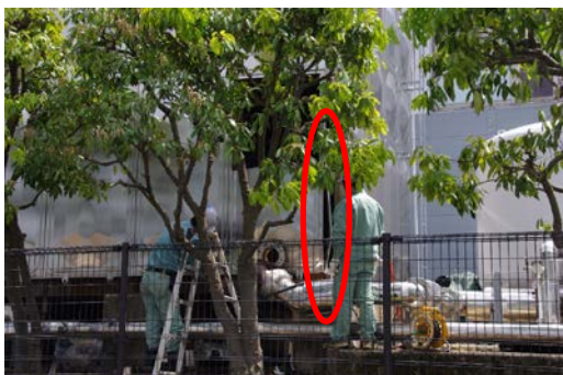
写真-2.1.1 隅角部下部の破損事例（熊本市 A 病院） （210m 3 ，熊本市南区）（バルジング事例）
