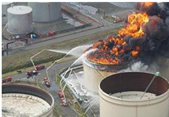
写真-1.1.3 十勝沖地震で破壊したナフサタンク
