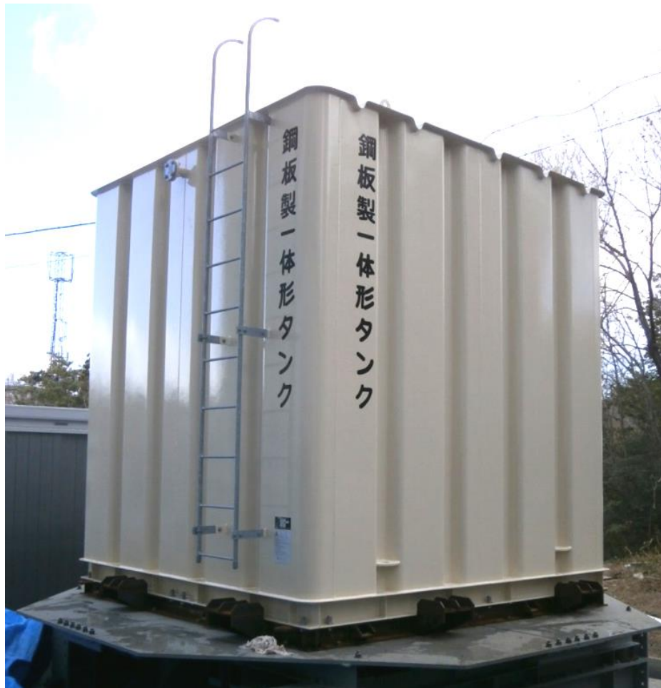
写真-7.3.1 鋼板製タンク
