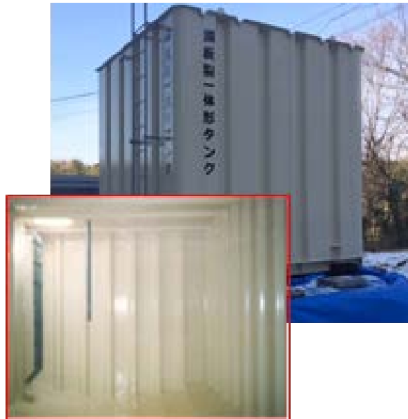
写真-6.1.1 鋼板製タンク
