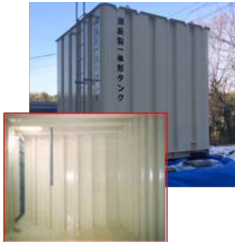
写真-4.1.2 鋼板製一体形タンク (鋼板タンク)
