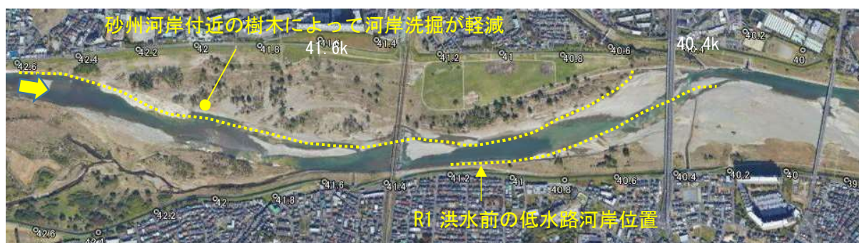
(b) 令和元年 10 月洪水後 (令和元年 11 月)
