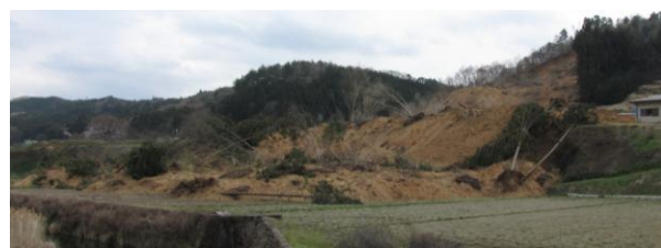
図-6 崩壊画像 (栃木県那珂川町押野)
