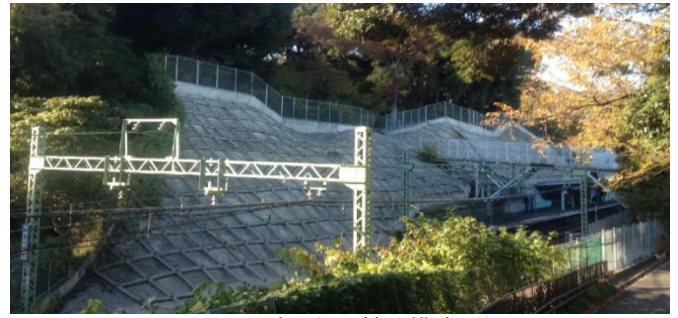
図-5 沿線の斜面補強構造の例
