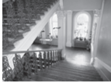
(32) Das Treppenhaus. Das Stiegen- geländer ist aus starkem Gußeisen mit hölzerner Führungsleiste gear- beitet.
