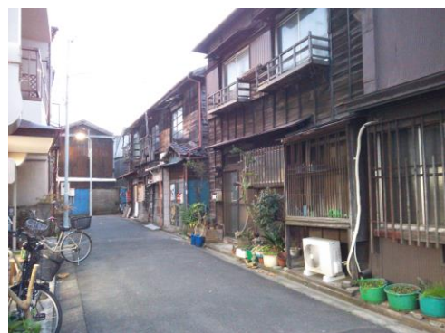
写真-1 台東区北部に見られる木造建築物
