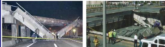
要因: 鉄筋腐食に伴う定着性能の劣化
